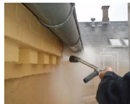
Hedtvandsspuling under udførelsen
