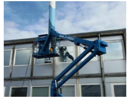
Afrensning af vinduespartier og betonbjælker foregår fra lift
