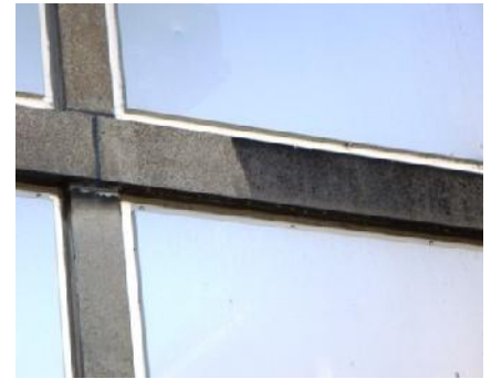
Sdr. Ringvej midt i processen - Overfladesnavs fjernes fra betonbjælke med højtryksspuling
