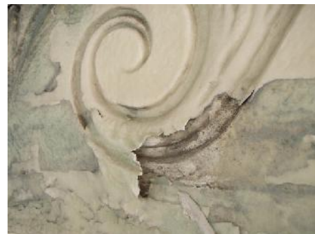
Kemiens effekt på tykt malingslag der skal fjernes fra puds ses tydeligt
