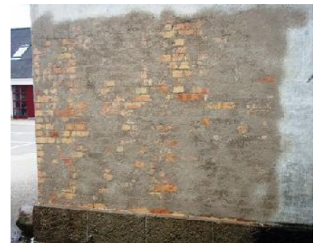
Afrenset område klar til ny overfladebehandling
