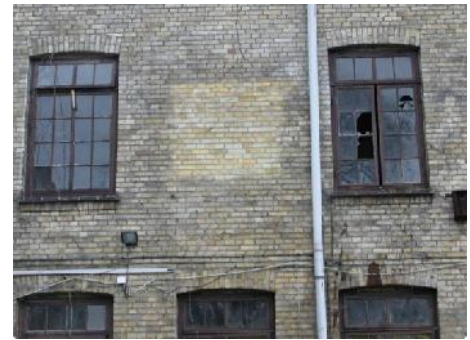
Afrensning af prøvefelter på teglsten, før afrensning til efterfølgende filts.
