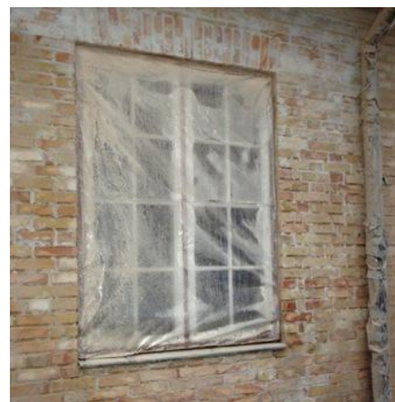
Vinduer, nedløbsrør m.m., afdækkes grundigt før sandblæsningen. (Kronborg)
