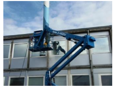
Afrensning af vinduespartier og betonbjælker foregår fra lift
