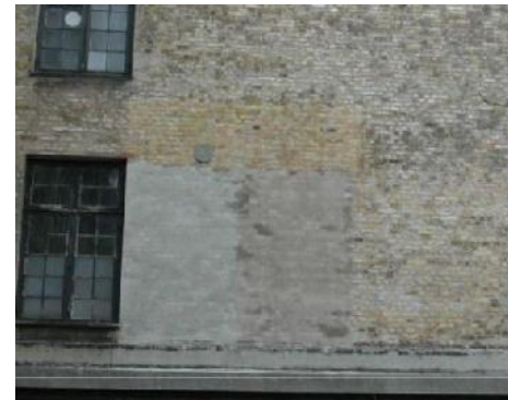
Filtsning af afrensede prøvefelter før afrensning af hele facaden
