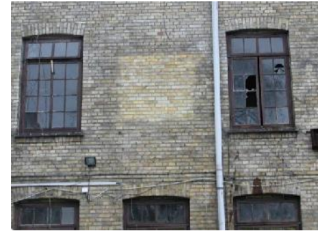
Renovering af Porcelæns-haven . Afrensning af prøvefelter på teglsten før afrensning til efterfølgende filts
