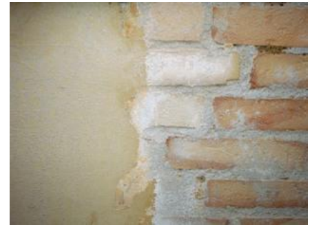
Maling og porøs puds afrenset til ny behandling
