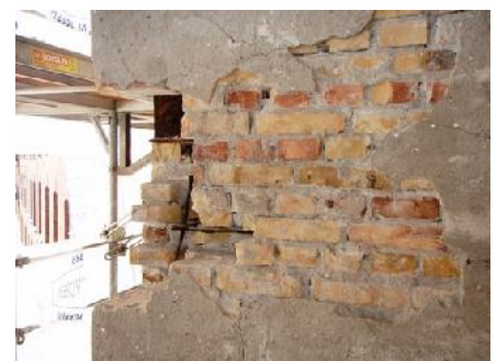
Efter sandblæsning, nedhugges murværk for at blotlægge armeringsjern og bæringer til ny overfladebehandling mod korrosion.
