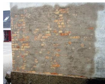
Afrenset område klar til ny overfladebehandling
