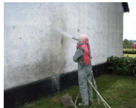
Afrensning af kalklag og porøs puds på facade
